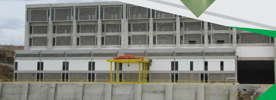
Estação de Bombeamento EBI-1
